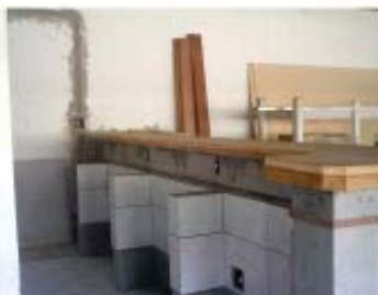
Montagem das instalações do futuro bar exclusivo.
