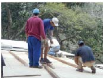
Operários trabalham no isolamento térmico do telhado.
