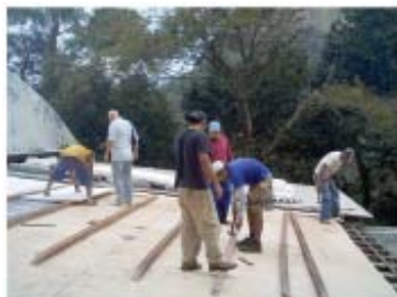
Instalação de isolamento térmico sob supervisão do presidente Esperança.
