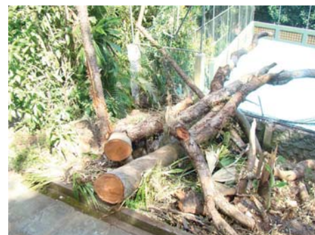
Além da murada da escada, o alambrado da quadra ficou bastante danificado
